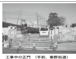
工事中の正門 (手前、秦野街道)
