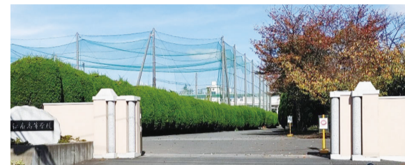
90周年記念事業で改修された正門
